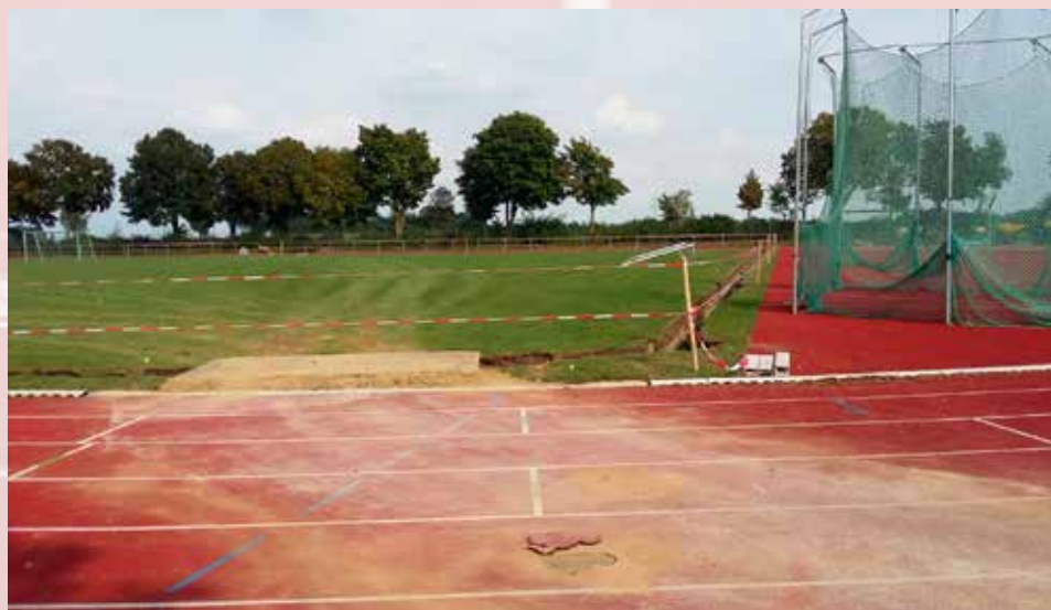
Als die Bahn von der Erde befreit war, trat leider ein für die Athleten nicht ungefährlicher Schaden zutage.
